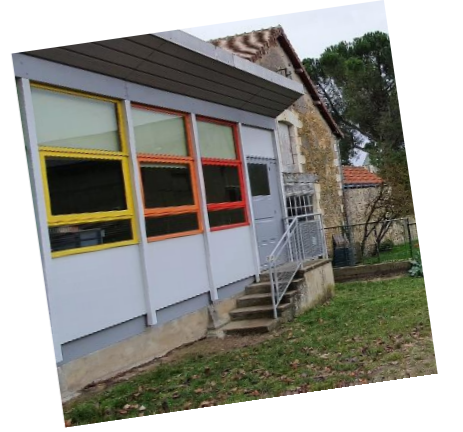
Rénovation-Isolation extérieure de l'internat Sainte Marie de l'Institution Saint Martin Saint Denis à Loches
