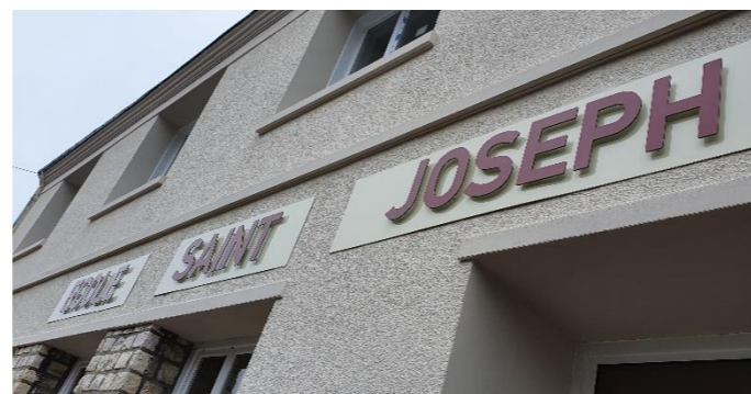
Rénovation complète d'un bâtiment à l'école St Joseph à Château-la-Vallière
