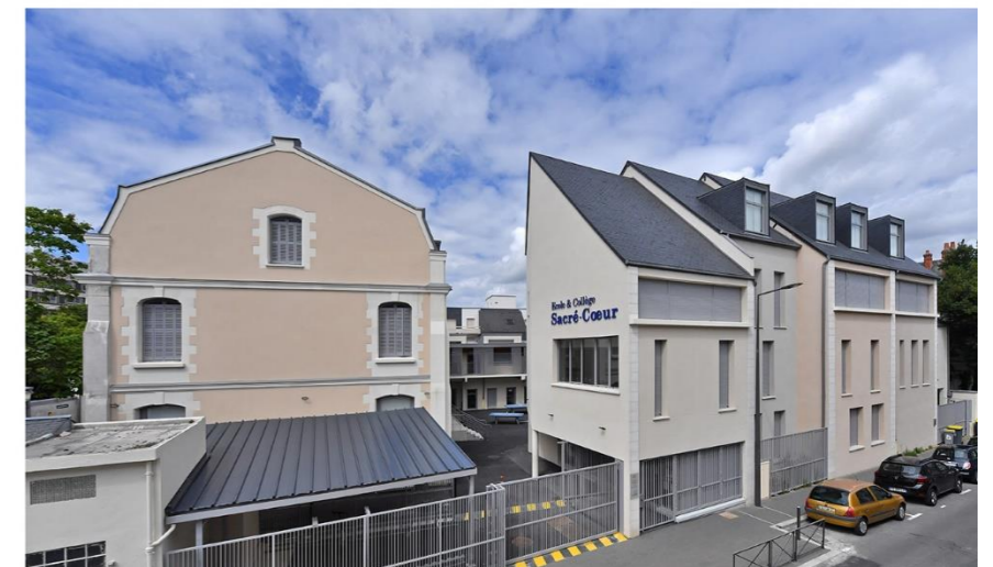
Réhabilitation-Reconstruction du site Maintenon pour Ecole-Collège Sacré-Coeur à Tours
